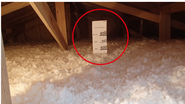
吹込み工法写真例
