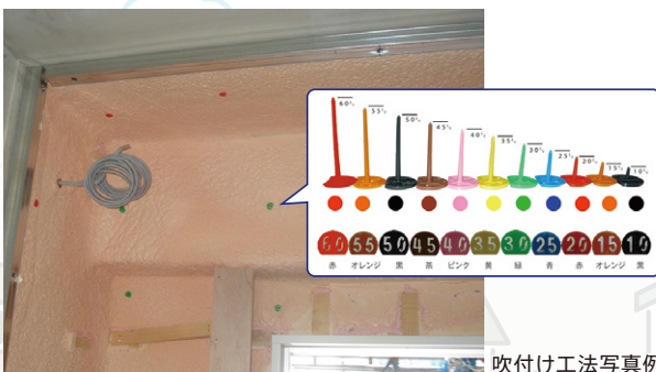
吹付け工法写真例
